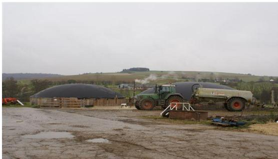
L'installation de méthanisation à la ferme du **GAEC Oudet** (Clavy Warby - Ardennes) traite 4 à 5 m<sup>3</sup>/jour de lisier de bovins laitiers (étable de 65 vaches laitières sur caillebotis) en codigestion avec des déchets de silos de stockage de céréales (1 700 tonnes entrantes par an dont 1 170 de lisier).
